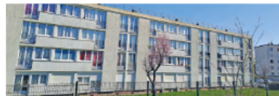
Les locataires interrogés font notamment état de moisissures, de portes et fenêtres cassées, d'absence de chauffage, et même de présence de cafards, et de rats à la cave.
