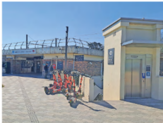
Parmi les réalisations majeures, l'installation de 2 ascenseurs, dont l'un, sur le parvis de la gare, permet à la fois d'accéder au quai 2 mais aussi de faire la traversée vers le centre-ville des Clayes.
