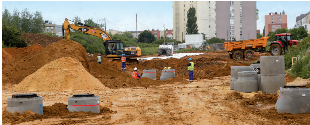
Pose de regards de visite.
